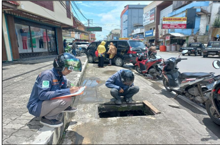
Gambar 20. Pengukuran Dimensi Drainase
