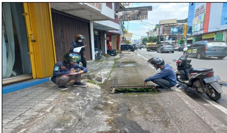
Gambar 19. Pengukuran Dimensi Drainase
