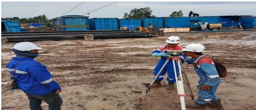
Gambar 11. Pengukuran Levelling Menggunakan Waterpass
