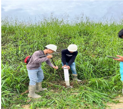
Gambar 3. Pemasangan patok batas wilayah
