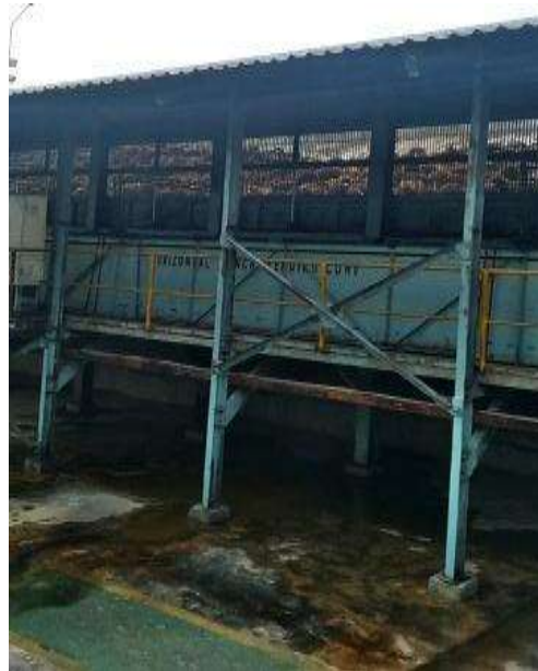
Gambar 5. Stasiun Loading ramp
