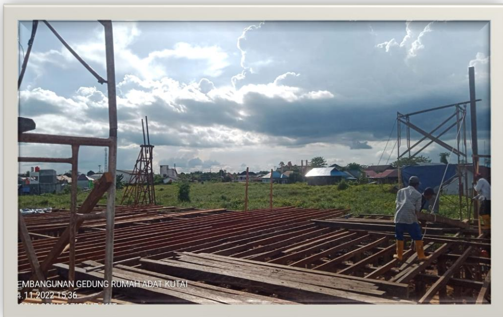
Gambar 14. Pemasangan Lantai
