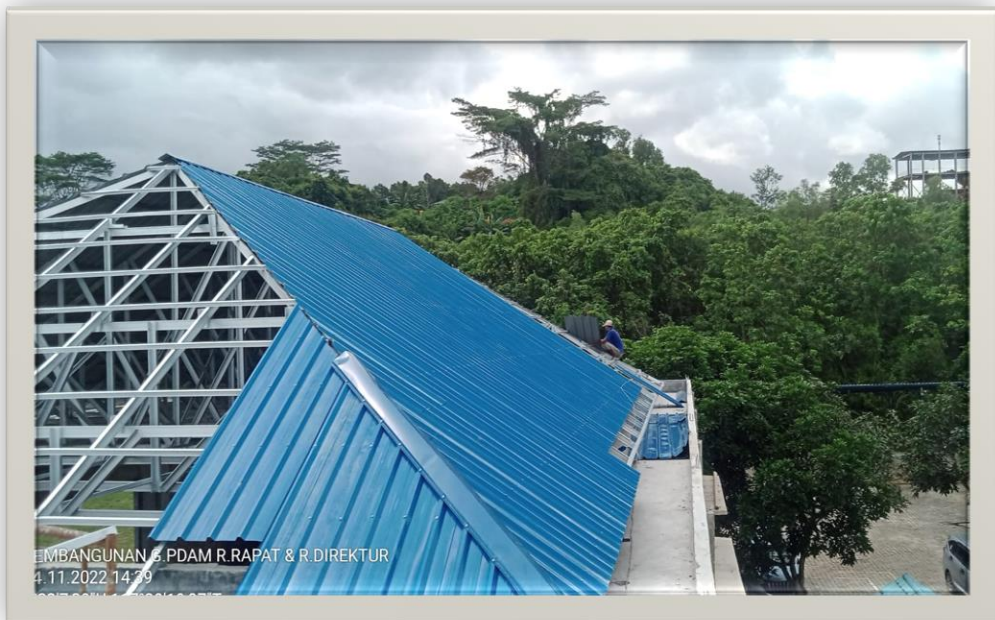
Gambar 16. Proses Pemasangan Atap
