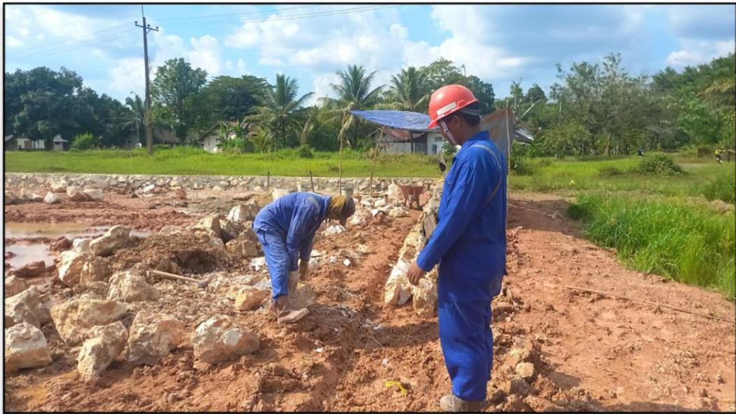
Gambar 8. Pengawasan Pekerjaan Pemasangan Pondasi Batu Gunung
