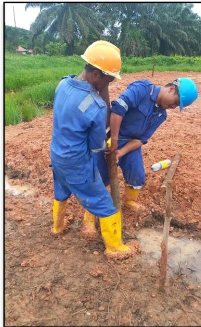
Gambar 4. Penentuan Titik Batas Sementara
