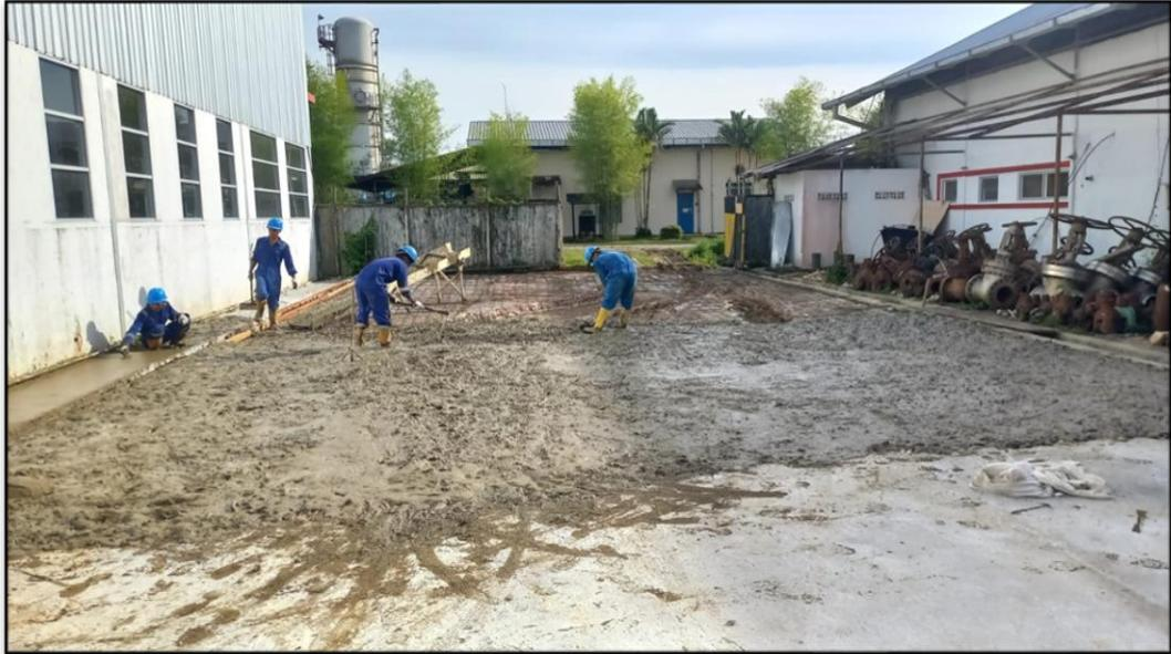
Gambar 9. Pengawasan Pekerjaan Pengecoran Open Storage
