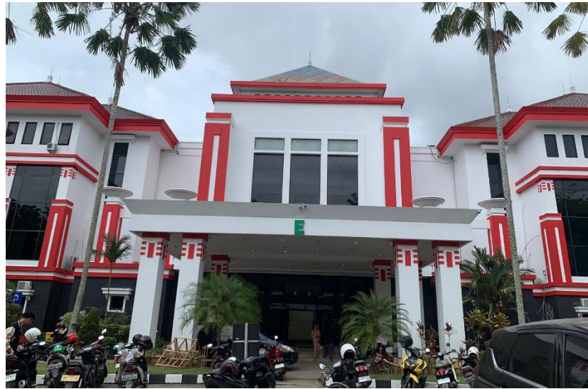
Gambar 5. Kondisi Depan Gedung E
