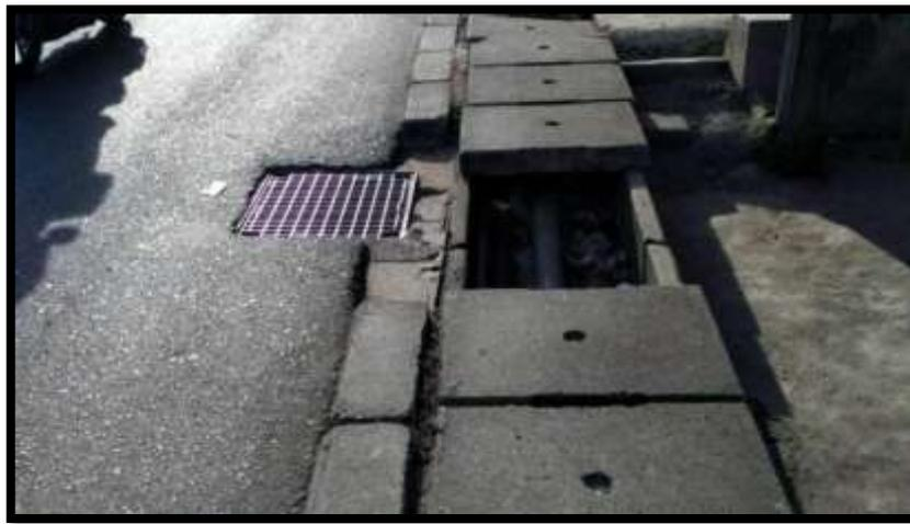
Gambar 4. Contoh saluran drainase permukaan.
