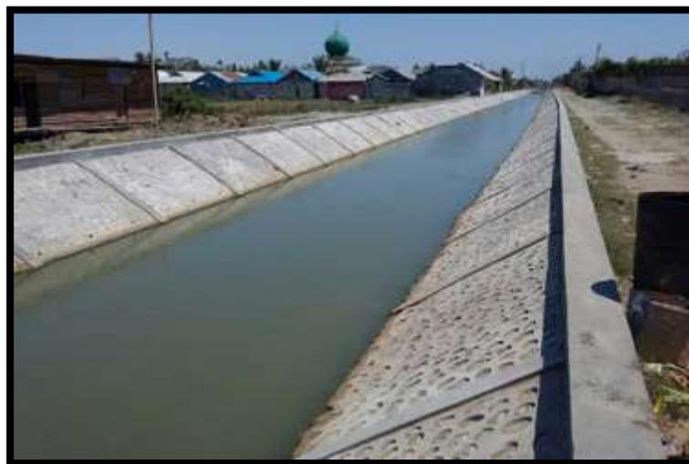
Gambar 3. Contoh saluran drainase buatan.
