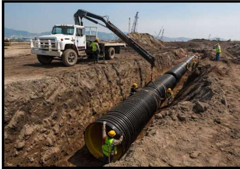
Gambar 5. Contoh saluran drainase bawah tanah.
