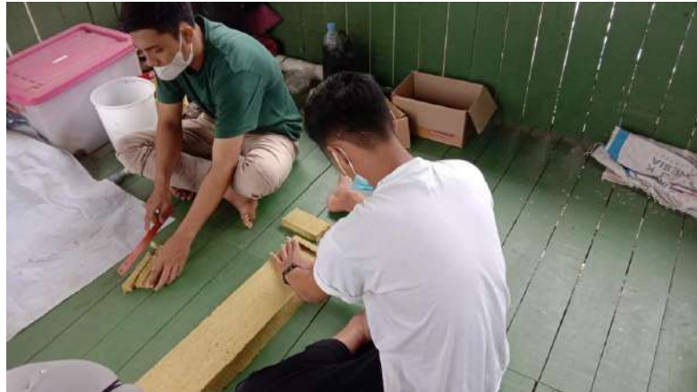
Lampiran 4. Pemotongan Rockwool
